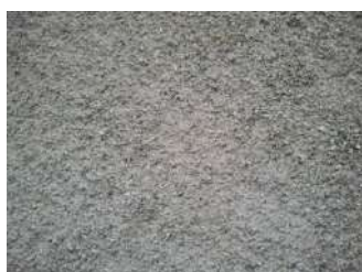
Enduit à la chaux au balai.
