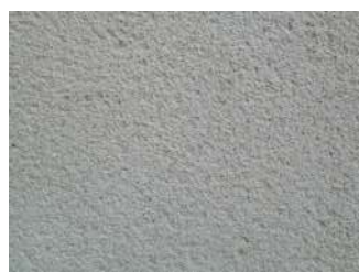
Enduit à la chaux gratté fin.
