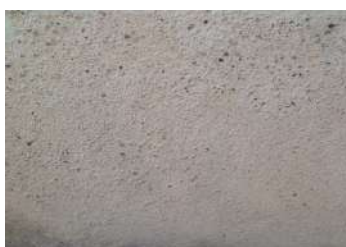
Enduit à la chaux brossé.
